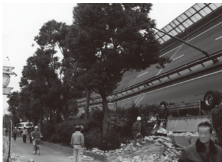
【阪神・淡路大震災】 阪神高速の倒壊現場(写真提供: 神戸市)
